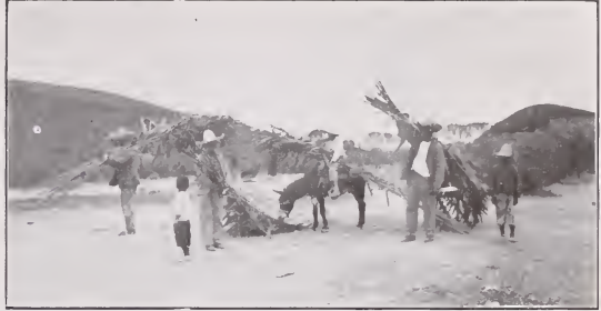
ESCUELA RURAL DE VAQUERÍA, ESTADO DE N. L.
